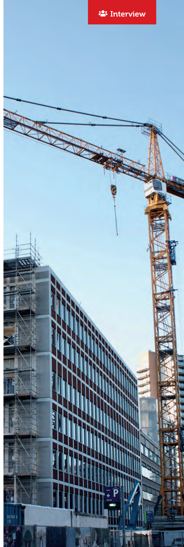
Er wordt hard gewerkt aan de verbouwing van het Ikazia Ziekenhuis
